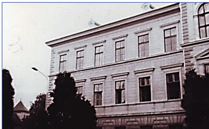
Fațada școlii noi
